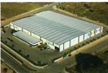
Protubsa Almacén Tarragona
