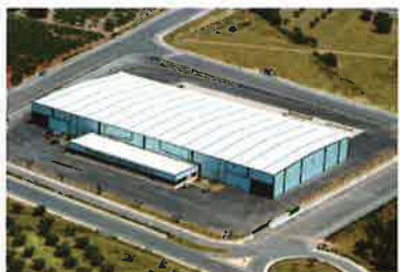
Protubsa Almacén Tarragona
