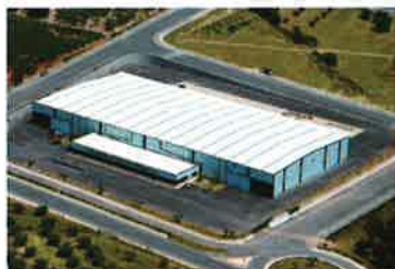
Protubsa Almacén Tarragona
