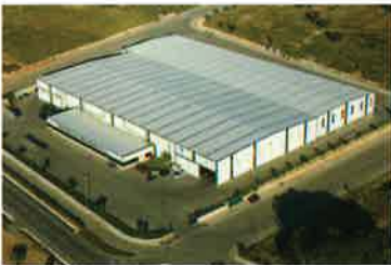
Protubsa Almacén Tarragona
