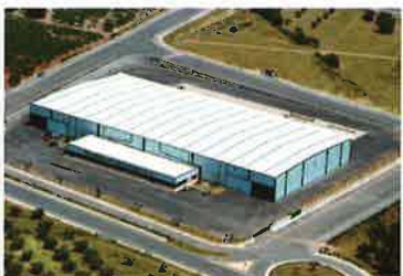
Protubsa Almacén Tarragona
